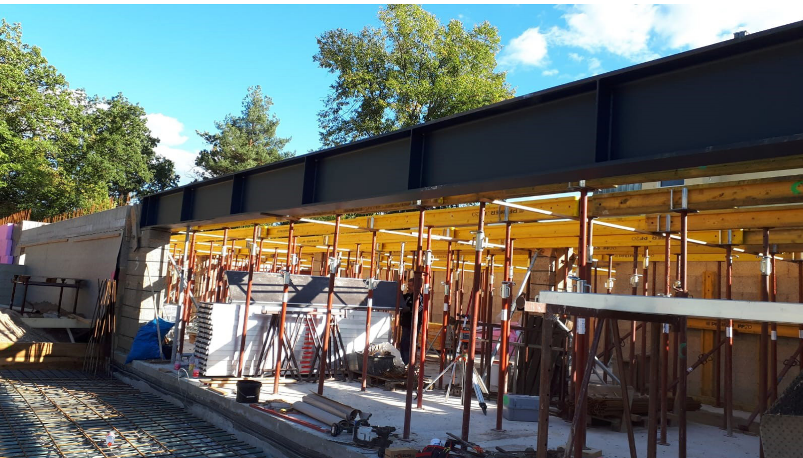
Tiefgarage-Stahlträger
