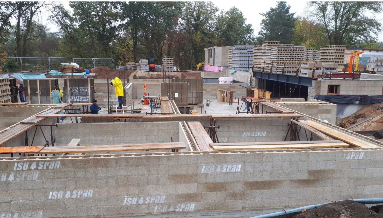
Tiefgarage unter Haus 1 und Haus 2
